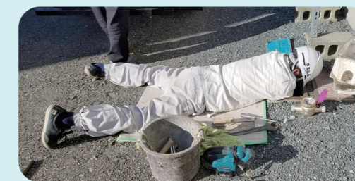
水道メーター取り替えの様子
